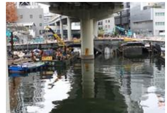
修理中の常盤橋
